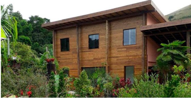
BR-040 - KM 65 (sentido Rio) - ARARAS - PETRÓPOLIS - R J.
